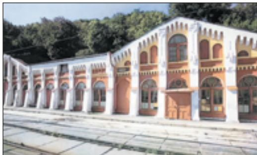
A kijevi vízvezeték-hálózat alsó gépháza
