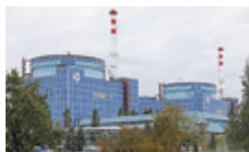
Fig. 27.6. CAE Hmelnițca are 2 blocuri atomice energetice
