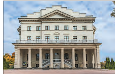
Палац К. Розумовського в м. Батурін (Чернігівська обл.). Архітектор Ч. Камерон. 1799 р. Відреставрований у 2003—2008 рр. Сучасний вигляд
