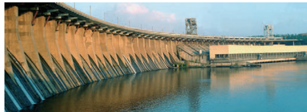
Fig. 18.1. Centrala hidroelectrică (CHEDnipro)
