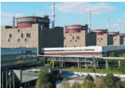
Fig. 18.2. Aspectul general al centralei atomoelectrice (CAE Zaporijie)
