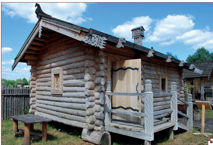
Будинок зі зрубу (реконструкція)
