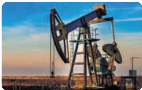
Instalare pentru extracția petrolului
