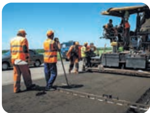
Lucrări de reparație a îmbrăcăminte rutiere
