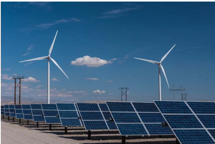
Рис. 200. Будівництво вітряних і сонячних електростанцій
