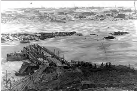
Початок будівництва Дніпрогесу
