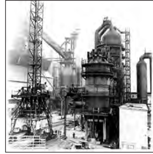
Будівництво домни на Криворіжсталі
