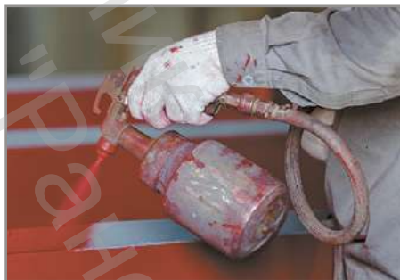
Рис. 33.4. Промислове фарбування сталевих конструкцій за допомогою фарбопульта
