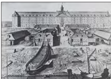
Будівництво корабля на верфі Амстердама
