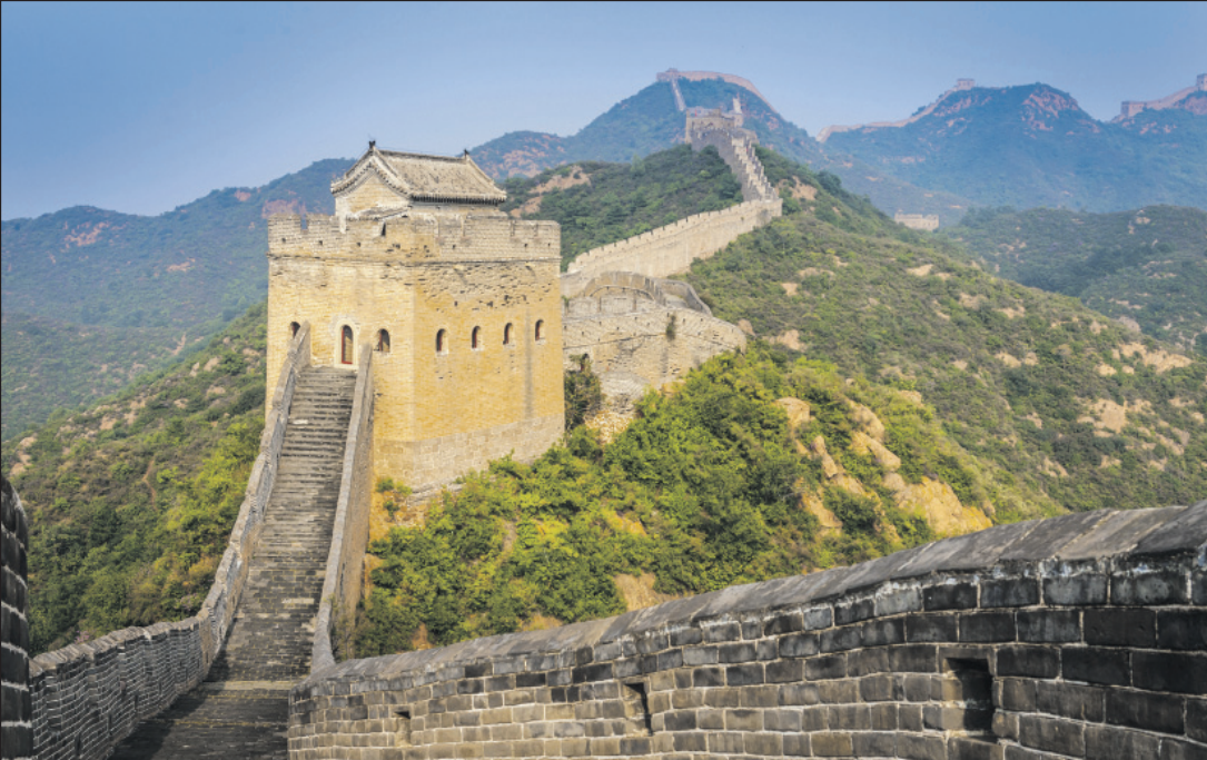
A Ming-dinasztia idején épült Nagy Fal szakasza. Jelenlegi külalak.
