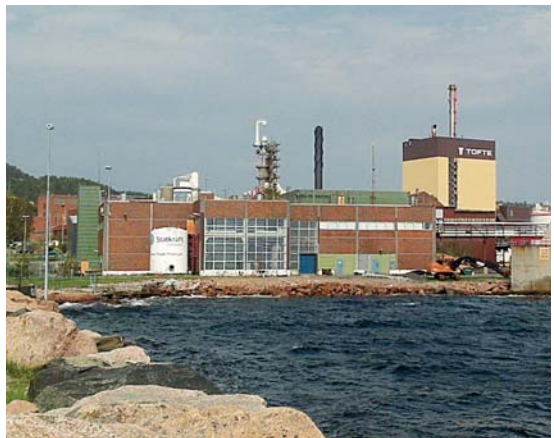
Rys. 7.7. Pierwsza na świecie elektrownia osmotyczna
