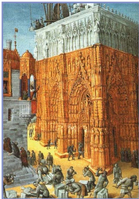
Жан Фуке. Будівництво храму. XV ст.
