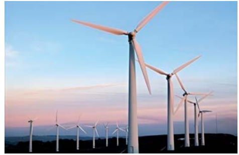
Мал. 38.8. Вітрова електростанція
