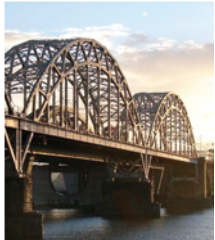
Дарницький міст через р. Дніпро
