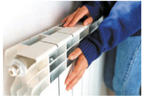
Опалювальні радіатори часто виготовляють із алюмінію
