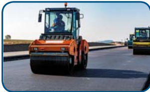
У будівництві доріг
