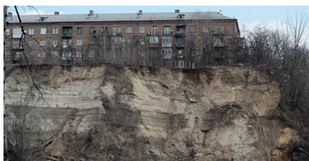
Мал. 69. Зсув ґрунту в Києві
