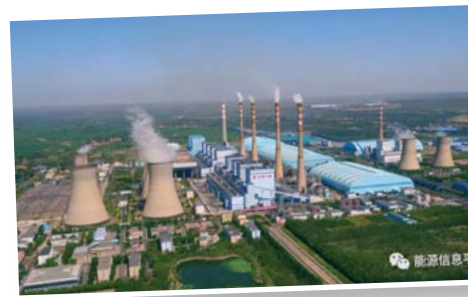
Мал. 257. Найбільша у світі електростанція, що працює на вугіллі (станом на 2022 р.). Розташована поблизу міста Хух-Хото в Китаї
