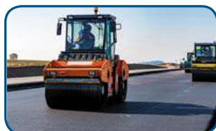
У будівництві доріг
