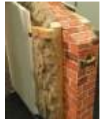
Утеплення будинкової стіни
