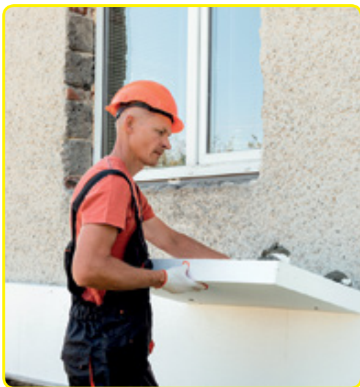
Мал. 14. Теплоізоляційні матеріали на будівництві
