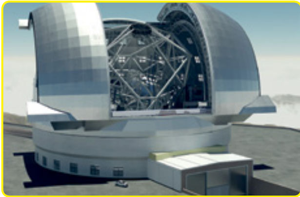
Мал. 120: 1 — Дуже Великий Телескоп E-ELT (дзеркало діаметром 39 м); 2 — Дуже великий масив радіотелескопів ім. Карла Янського
