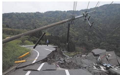
Мал. 40.6. Руйнівні наслідки землетрусу
