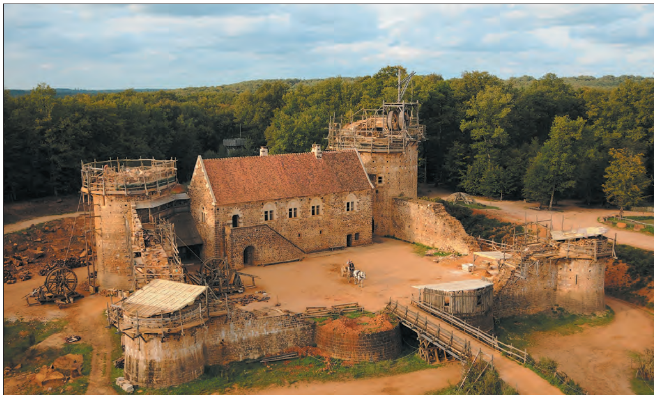
Construcția castelului medieval Guedelon în Burgundia (Franța)
