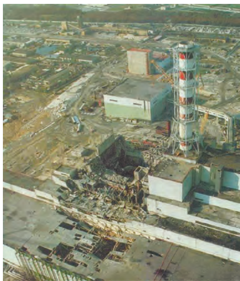
↑ Зруйнований четвертий реактор ЧАЕС
