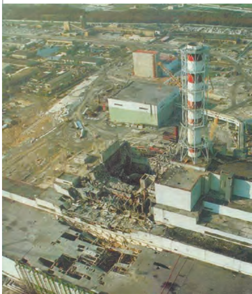
↑ Зруйнований реактор четвертого енергоблока ЧАЕС
