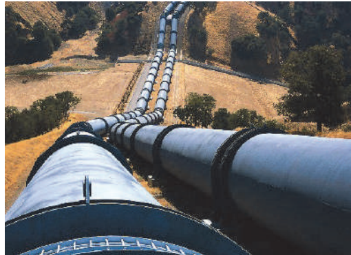
Одна з дiлянок газопроводу Дашава – Киiв
