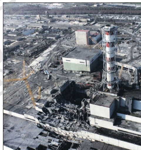
Зруйнований 4-й енергоблок Чорнобильської АЕС унаслідок аварії. 1986 р.
