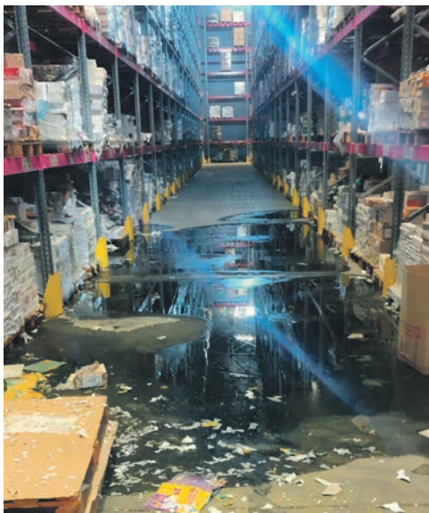
Пошкоджений логістичний центр видавництва «Ранок», що не припинило роботу. Квітень 2022 р.
