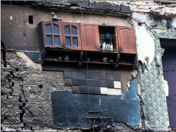
Стіна зруйнованого будинку в місті Бородянка (Київська область). Вціліла кухонна шафа з півником стала символом стійкості й нескореності. Березень-квітень 2022 р.
