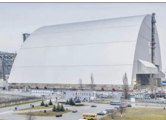
Арка безпеки над 4-м енергоблоком Чорнобильської АЕС. 2016 р.
