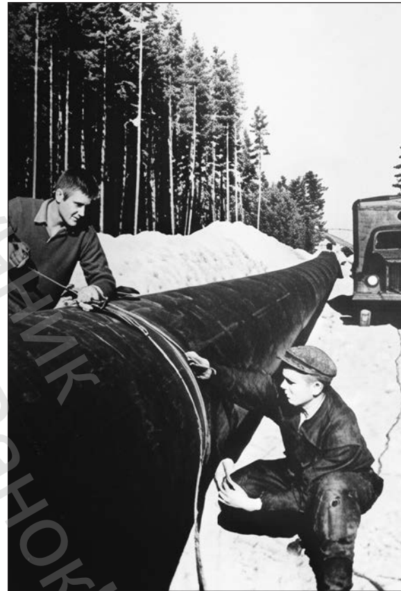
Будівництво газопроводу «Шебелинка—Острог». 1960 р.
