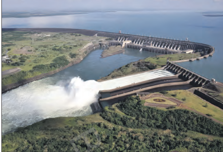
Мал. 1. «Ітайпу» (Бразилія) — одна з найпотужніших ГЕС світу (14 МВт). Загальна довжина греблі становить понад 7 км, висота — 196 м.
