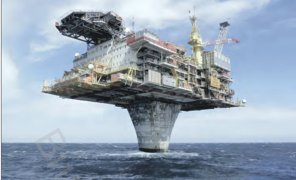
Мал. 3. Унікальна нафтодобувна платформа «Драген» (Норвегія) є справжнім дивом інженерної думки: багатопверхова споруда стоїть на одній 280-метровій бетонній «нозі», з яких 250 м ховається у морі.
