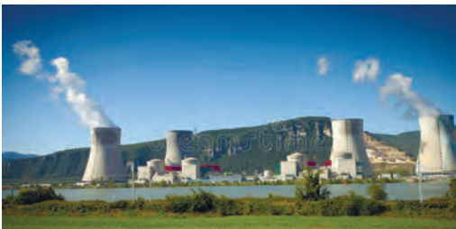
Des. 46. Centrala nucleară din Moselle (Franța)
