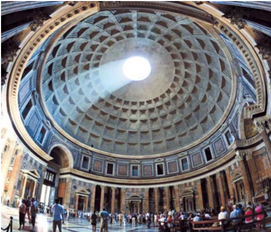
Око Пантеона. Сучасне фото. Світло проникає у внутрішнє приміщення крізь отвір у куполі.
