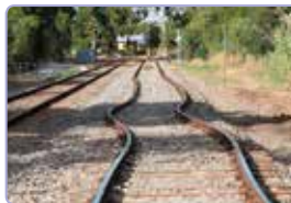
20. ábra. Objektumok, amelyeknél figyelembe kell venni az anyagok hőtágulásának jelenségét
