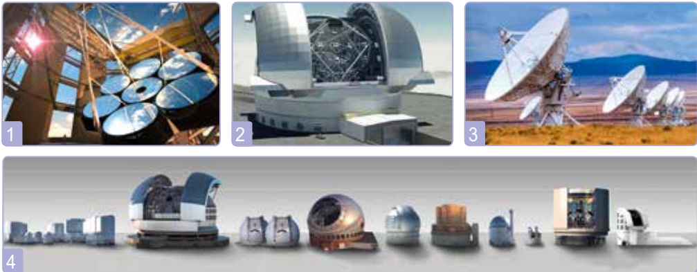
140. ábra. 1 – nagy Magellán teleszkóp (7 tükör, 8,4* m átmérővel); 2 – nagyon nagy E-ELT teleszkóp (39* m átmérőjű tükörrel); 3 – Karl G. Jansky nagy rádióteleszkóp obszervatórium; 4 – a teleszkópok méreteinek összehasonlítása
