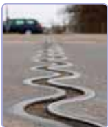
20. ábra. Objektumok, amelyeknél figyelembe kell venni az anyagok hőtágulásának jelenségét
