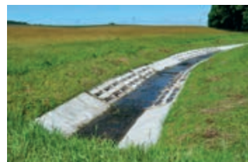
Ryc. 181. Kanał dla osuszania zablokowanej miejscowości
