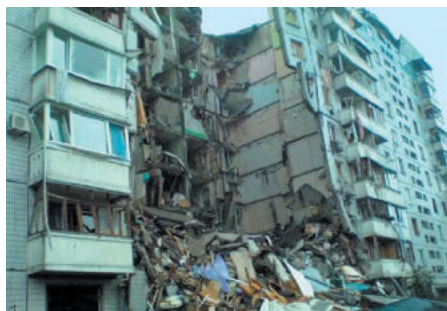
Rys. 23.5. Skutki eksplozji gazu ziemnego w wielopiętrowym budynku mieszkalnym, 13 października 2007 roku, m. Dniepr
