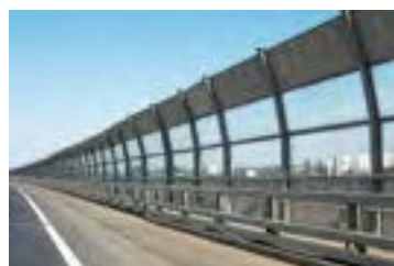
Rys. 6. Dźwiękochłonne ekra-ny, ustawiane obok autostrad, kilkukrotnie zmniejszają poziom hałasu
