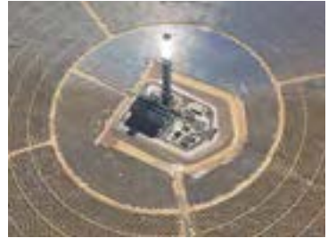
Rys. 10. Jedna z największych na świecie elektrowni słonecznych – „Ivanpah” (czyt. Ajwanpah) (USA, Kalifornia). 173 tys. zwierciadeł odbija światło słoneczne i skierowuje je na wierzchołki trzech wież, na których znajdują się kotły z wodą. Gorąca para trafia na tarcze turbin, znajdujących się wewnątrz wież
