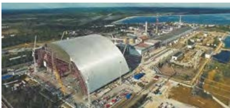
Rys. 27.8. Sarkofag nad 4-m blokiem energetycznym elektrowni atomo- wej w Czarnobylu
