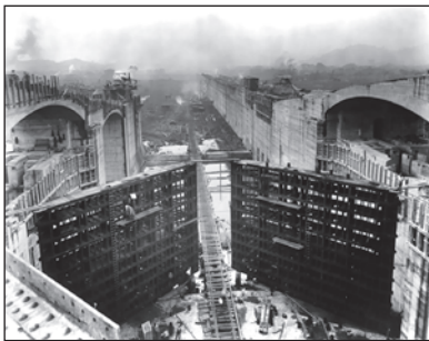
Будівництво Панамського каналу. Початок XX ст.
