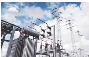
Stație de transformatoare
